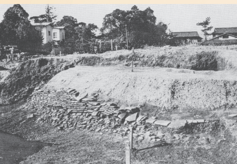
八角塔基壇の調査当時の様子
